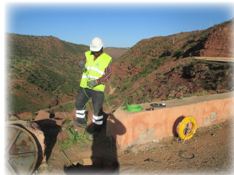
Installation d'un câble numérique pour le système de surveillance sismique.
