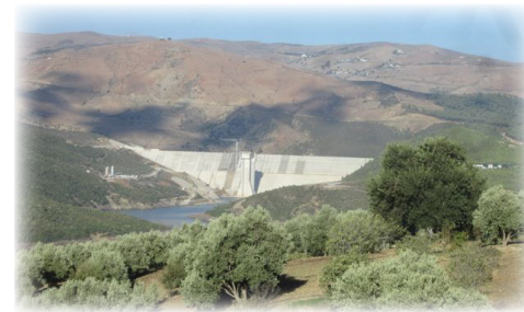
Le Barrage de Oued Martil comprend un barrage de remblai en béton sur Oued Mohjerat et un barrage secondaire en terre.
